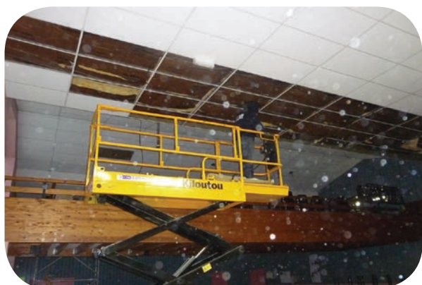
Réfection isolation plafond
