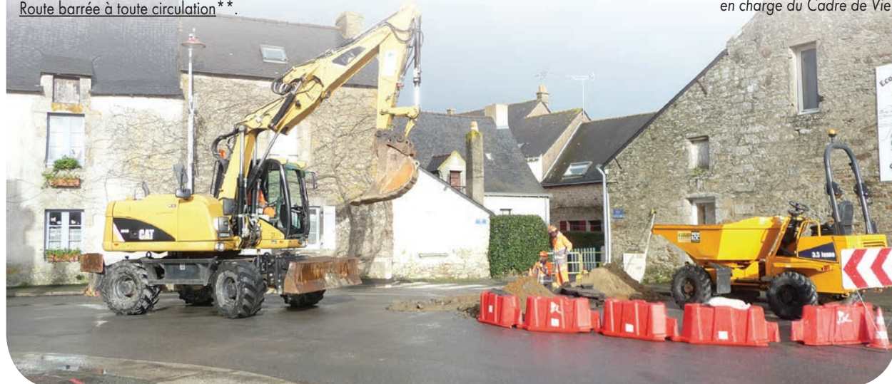
Démarrage des travaux rue du Pays Blanc
