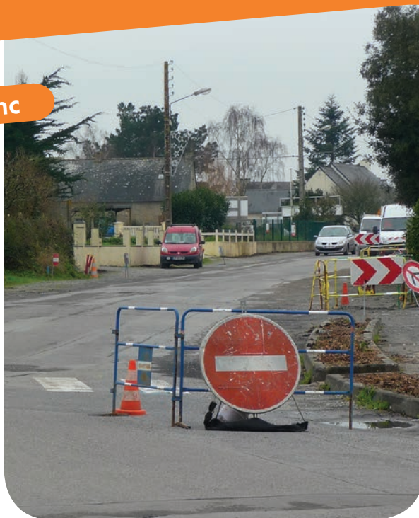
Aménagement de la rue du Pays Blanc
