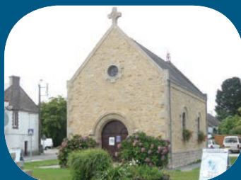
Rénovation de la chapelle
