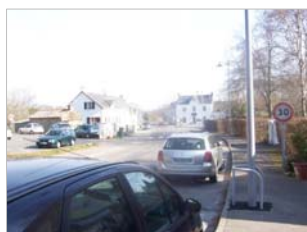
Aménagement d'une zone 30 rue la Duchesse Anne dans le bourg
