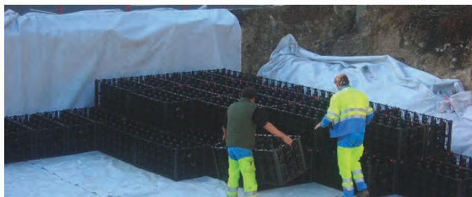
Pose des modules plastiques constituant le réservoir enterré (Sarzeau, GBS)
