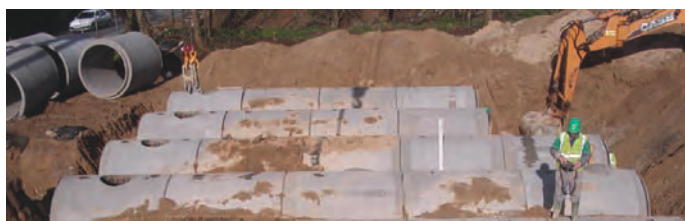
Pose des modules plastiques constituant le réservoir enterré (Sarzeau, GBS)
