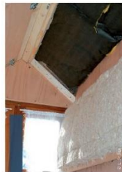
Construction d'un caisson isol
