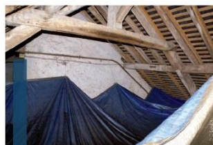
Bâches de protection dans un comble
