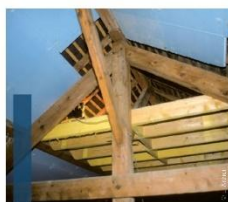
Installation d'un plancher
