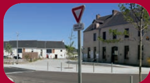
Travaux du centre-bourg
